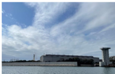
和歌山下津港海岸(海南地区)船尾南護岸等築造工事
