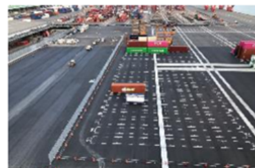
六甲アイランド地区RS-B・C造成工事
