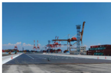
神戸港ポートアイランド(第2期)地区荷さばき地(拡張部)舗装等工事
