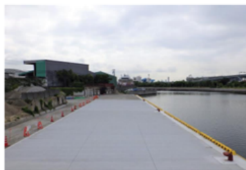
尼崎西宮芦屋港鶴町物揚場改築工事
