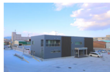
神港衛生株式会社荇藻センター新築工事
